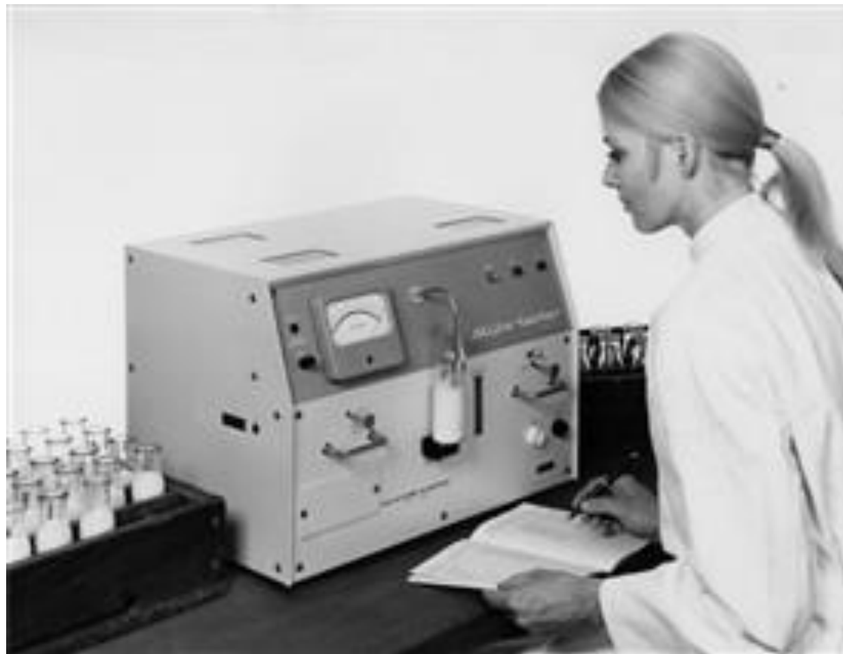
Måleapparat til bestemmelse af fedtindhold i mælk, 1965. Foto: Foss
